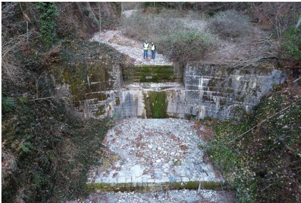
Abbildung 19: Blick auf die Sperre Nr. 15 mit Vorsperre (Blick gegen die Fliessrichtung). Quelle: Flussbau AG SAH.
