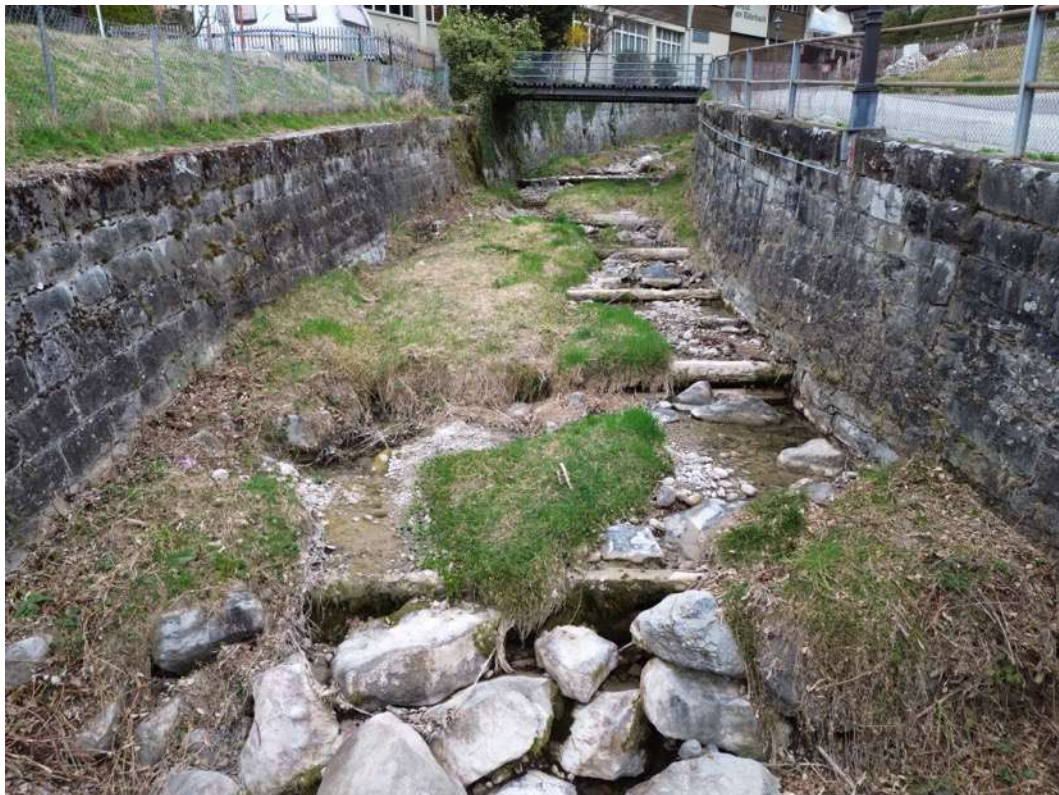
Abbildung 36: Allgemeines Erschei- nungsbild des Gerinnes im Abschnitt Trafostation- Staatsstrasse. Blick ge- gen die Fliessrichtung. Quelle: Flussbau AG SAH.
