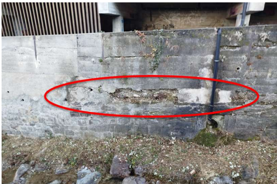
Abbildung 33: Blick auf die rechtsufrige Mauer unterhalb der Blochstrasse. Fliessrich- tung von rechts nach links. Quelle: Flussbau AG SAH.
