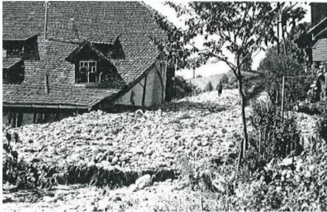
Abbildung 1: Aufnahme vom 20. Juli 1937 vom unteren Be- reich der Länggasse, mit dem Klösterli auf der lin- ken Seite; im Bereich des Klösterli sind Geschiebe- ablagerungen von rund 2 m Mächtigkeit erkennbar. Quelle: storme.bafu.ad- min.ch
