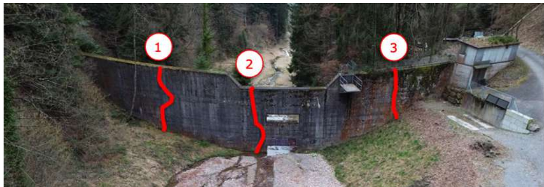
Abbildung 22: Die Abschluss sperre ist an drei Stellen durchge- rissen (rote Linien). Quelle: Flussbau AG SAH
