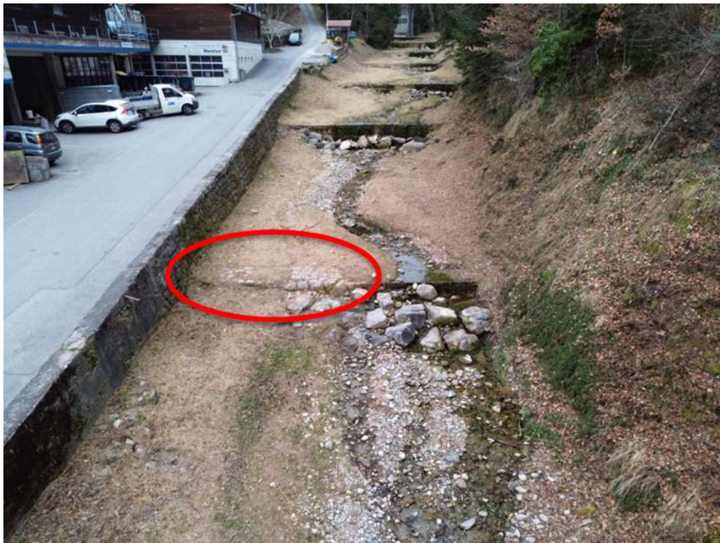
Abbildung 26: Blick gegen die Fliessrichtung auf einen Rest der best. Pflasterung. Quelle: Flussbau AG SAH.
