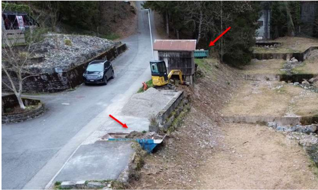
Abbildung 25: Blick auf die Mulden gegen die Fliessrichtung. Quelle: Flussbau AG SAH.
