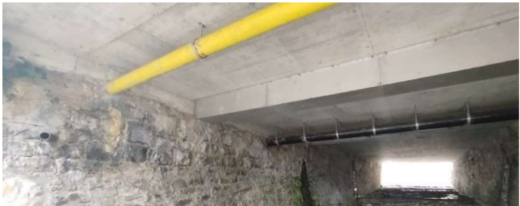
Abbildung 32: Blick gegen die Fliessrichtung im Durchlass Blochstrasse. An der Decke sind verschiedene Werkleitungen befestigt. Quelle: Flussbau AG SAH.
