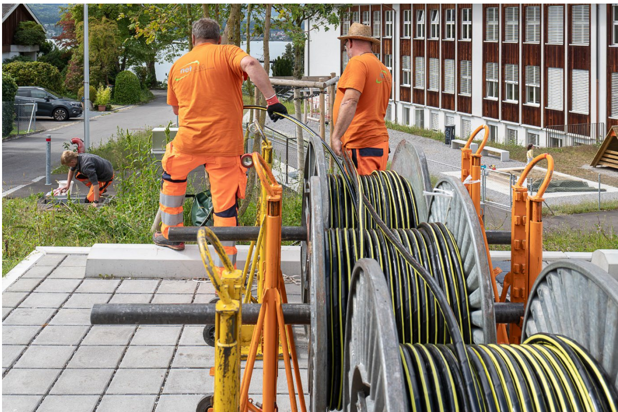
Bilder: Kabeleinzug beim Schulhaus Friedbühl
