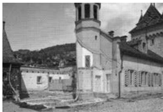
Bau eines Gastrobetriebes wird ehrgeizig vorangetrieben. Geschätzte Kosten Fr. 1 Mio.
